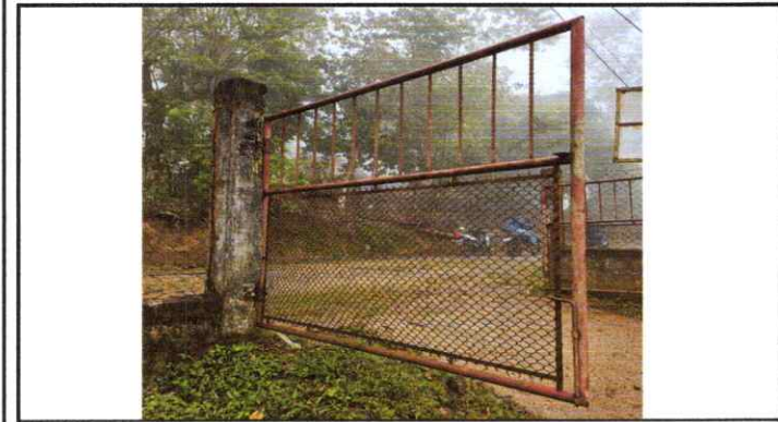
Sustitución de portón de metal
