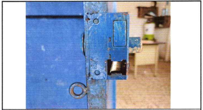
Sustitución de chapa
