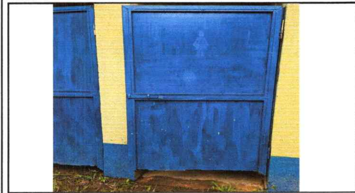
Mantenimiento a estructura de puerta
