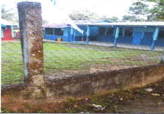
Reparación de muro perimetral de block con tubo hg y malla galvanizada, soleras intermedias y columnas
