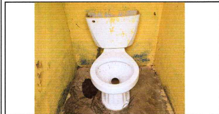
Sustitución de accesorios de inodoro
