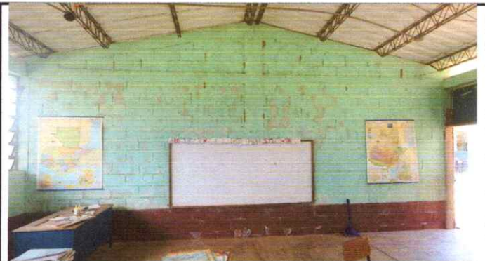
Repello en muro
