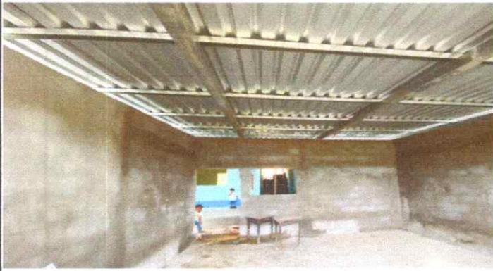
Sustitución de lámina troquelada aluzinc calibre 26
