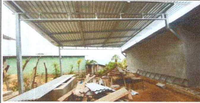
Sustitución de lámina troquelada aluzinc calibre 26
