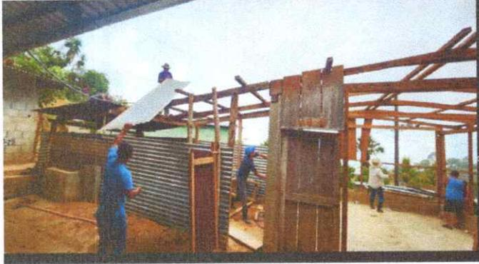
Sustitución de lámina troquelada aluzinc calibre 26
