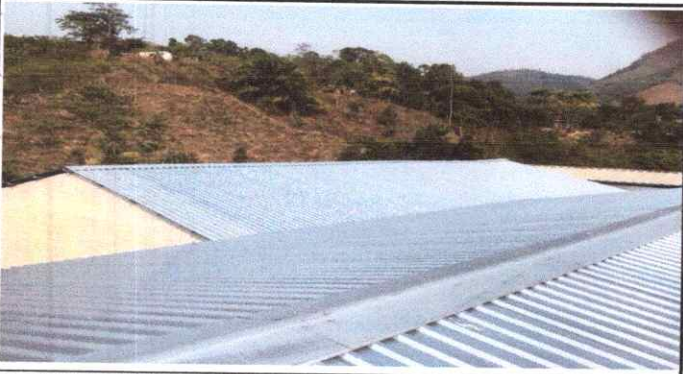
19.8 INTALACIÓN DE LAMINA TROQUELADA ALUZINC
