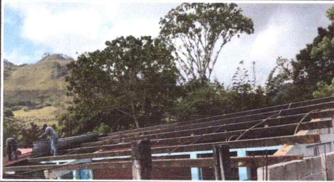
1.1 SUSTITUCIÓN DE LÁMINA TROQUELADA ALUZINC CALIBRE 26
