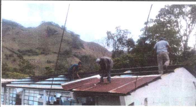
19.8 INTALACIÓN DE LÁMINA TROQUELADA ALUZINC
