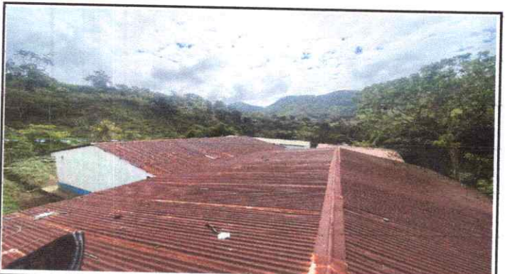
19.8 INSTALACIÓN DE LÁMINA TROQUELADA ALUZINC
