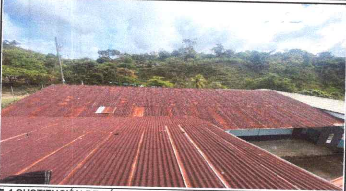
1 SUSTITUCIÓN DE LÁMINA TROQUELADA ALUZINC CALIBRE 26
