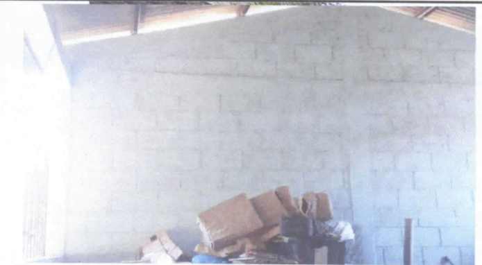
foto 10 pintura en muros interiores
