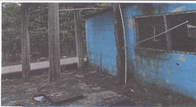
foto 11 pintura en muros exteriores
