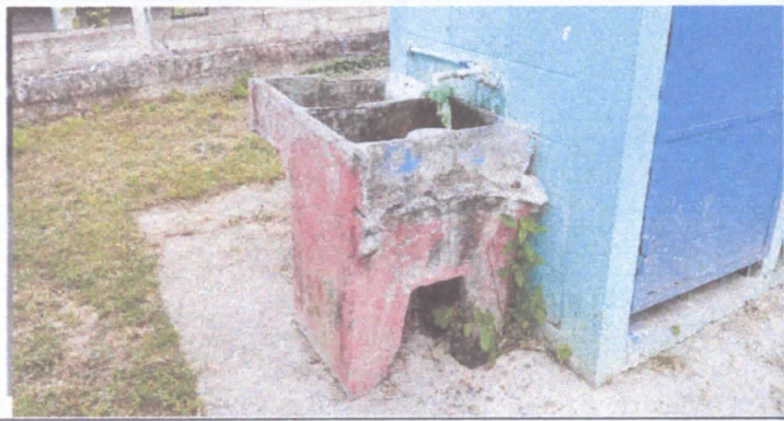
foto 13 sustitucion de pila de 2 lavadores
