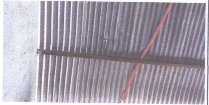
foto 2 cubierta de lamina para modulo de aula
