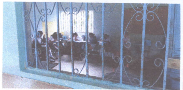
foto 6 mantenimiento a balcones
