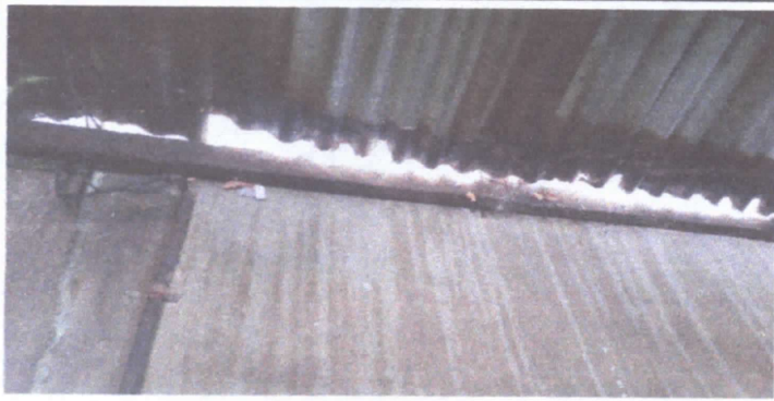
foto 1 cubierta de lamina para cocina,
