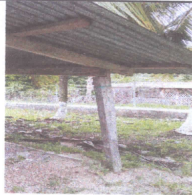
foto 4 sustitucion de estructura de soporte de madera por metal
