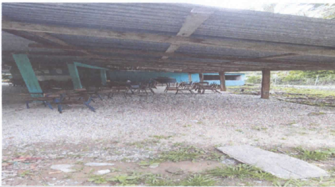
foto 9 reparacion de piso de torta de concreto en salon
