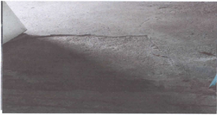
foto 7 reparacion de piso de torta de concreto en cocina
