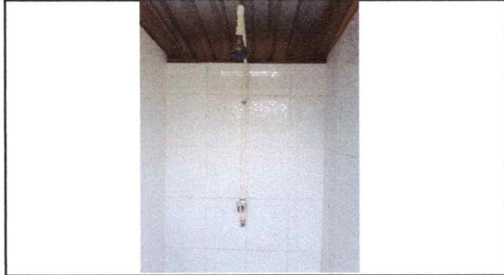
SUSTITUCIÓN DE MEZCLADORA PARA DUCHA
