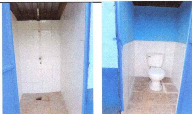
SUSTITUCIÓN DE PISO CERAMICO (ANTIDESLIZANTE EN SANITARIOS Y DUCHAS)
