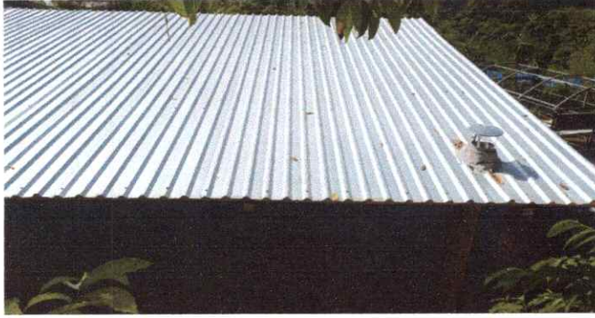
SUSTITUCIÓN DE LAMINA POR LAMINA TROQUELADA ALUZINC CALIBRE 26 (COCINA)
