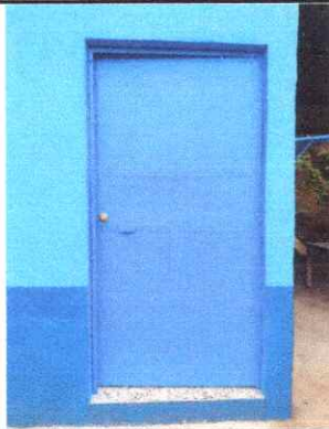
SUSTITUCIÓN DE PUERTA (COCINA)
