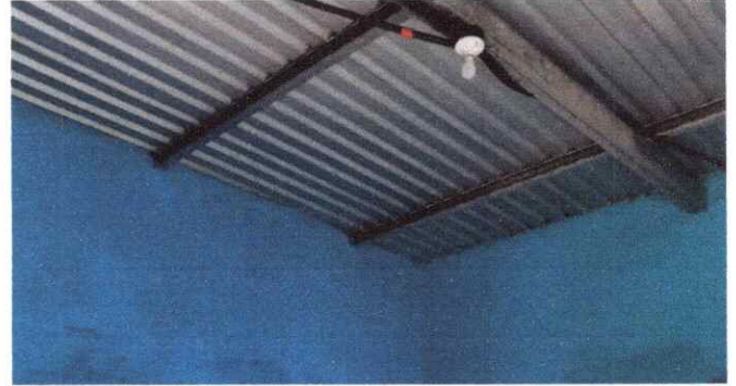
SUSTITUCIÓN DE ESTRUCTURA SOPORTE DE MADERA, POR METAL (COCINA)
