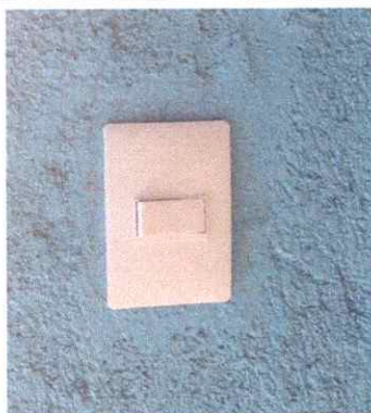
SUSTITUCIÓN DE INTERRUPTORES SIMPLES (COCINA)
