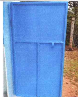
SUSTITUCIÓN DE PUERTAS DE SERVICIOS SANITARIOS
