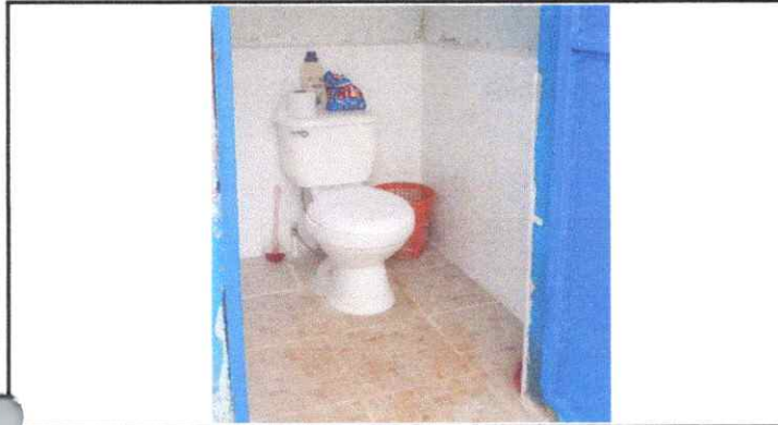
SUSTITUCION DE INODOROS
