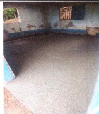
SUSTITUCIÓN DE TORTA DE CONCRETO (COCINA)
