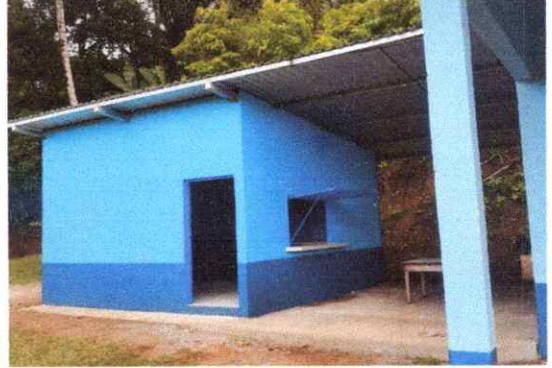
REPELLO EN MURO (COCINA)
