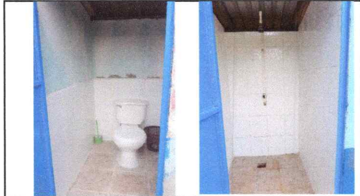
SUSTITUCIÓN DE AZULEJOS DE BAÑOS Y DUCHA
