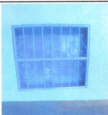
SUSTITUCIÓN DE BALCONES DE METAL (COCINA)
