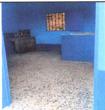
SUSTITUCIÓN DE PISO GRANITO (COCINA)
