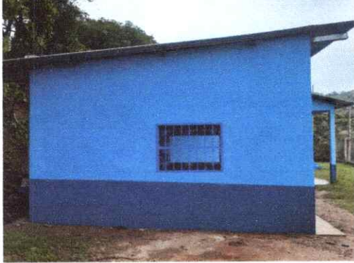
REPELLO EN MURO (COCINA)
