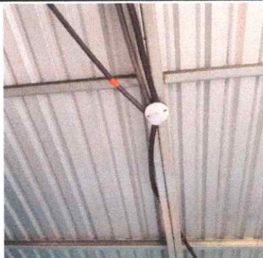
SUSTITUCIÓN DE DUCTO ELÉCTRICO Y ACCESORIOS (COCINA)
