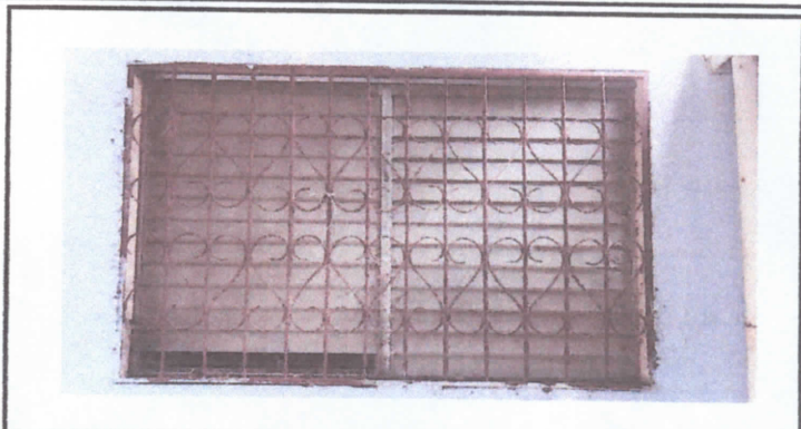
Mantenimiento a balcones de metal
