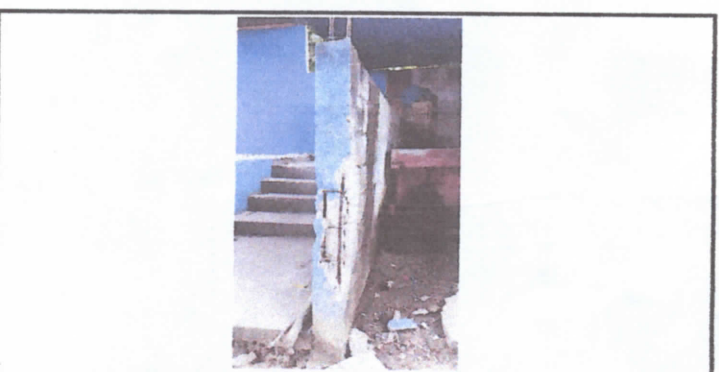
Pintura en muros exteriores e interiores
