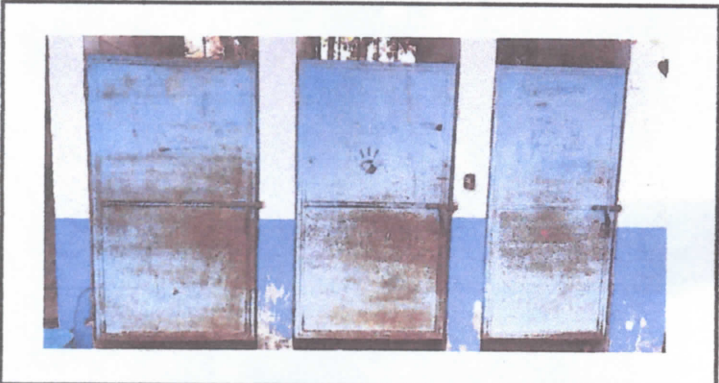
Mantenimiento a estructura (lijado, cepillado, aplicación de pintura)
