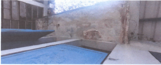
Impermeabilización de loza
