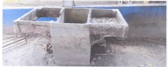
Sustitución de pila de dos lavaderos
