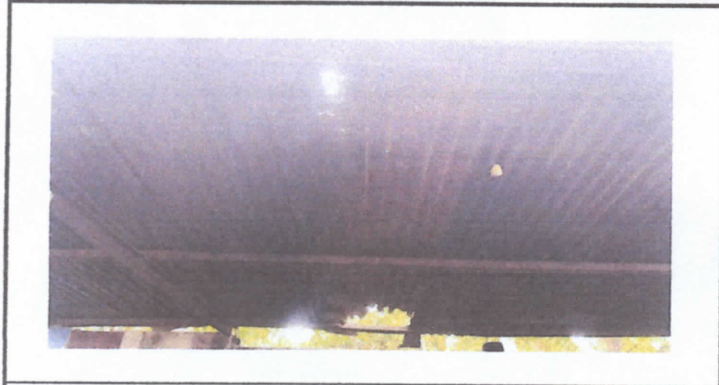
Sustitución de lámina troquelado aluzinc calibre 26
