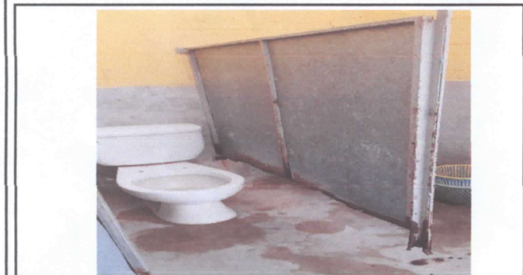
Foto 3: Cambio de estructura metálica de las divisiones de los sanitarios de varones y puertas
