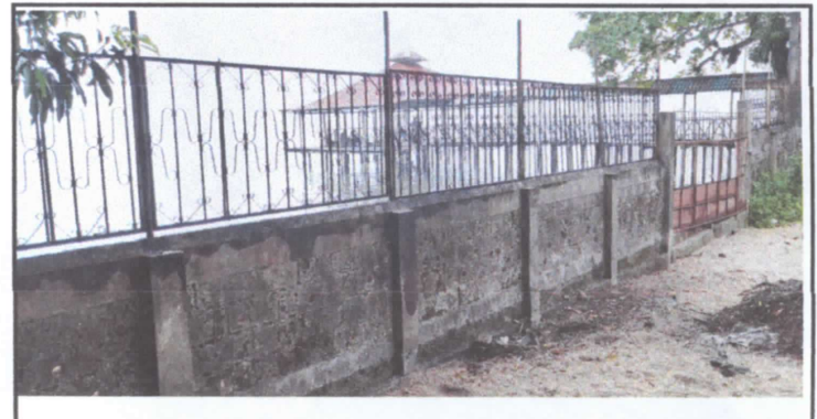
Foto 10: Ligado y pintado de Balcones de muro perimetral de orilla del lago
