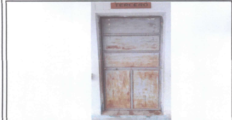
Foto 1: Ligado y Pintado de puertas aula, sanitarios bodega de las mismas medidas y dimensiones
