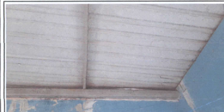
Foto 11: Cambio de Lámina en Aulas
