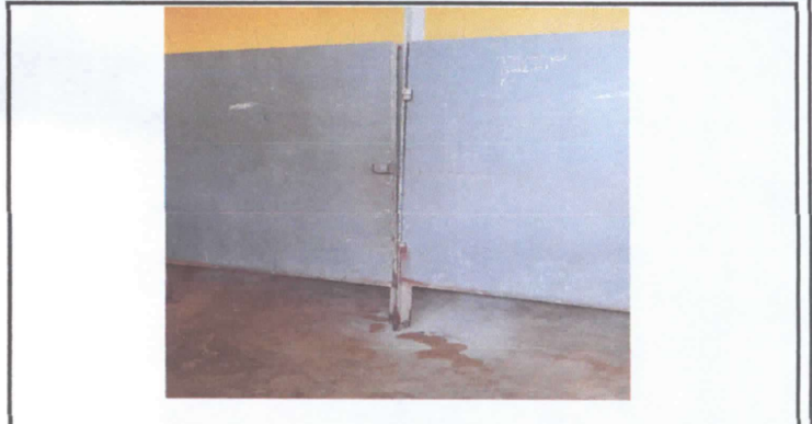
Foto 2: Reparación de Estructura en baños de Niñas
