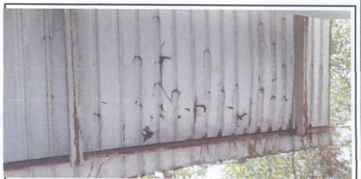
Foto 6: Cambio de lámina troquela y costatera.
