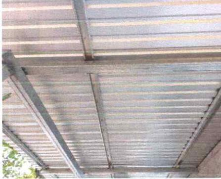
Foto 1: Cambio de Estructura de Madera por Metal y cambio de Lámina.
