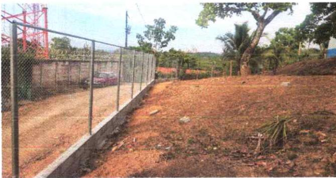
Foto 3: Reparación de Cernca perimetral de la escuela, cambio de postes de madera por tubos galvanizados y Malla.
