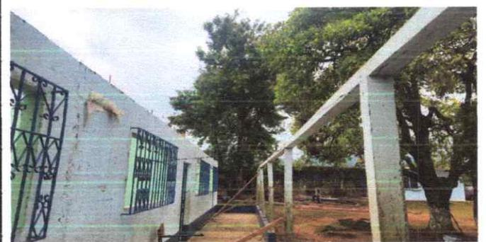
FOTO 6: Sustitución de parales de madera a metal
