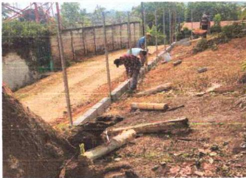
Foto 3: Reparación de Cernca perimetral de la escuela, cambio de postes de madera por tubos galvanizados y Malla.
