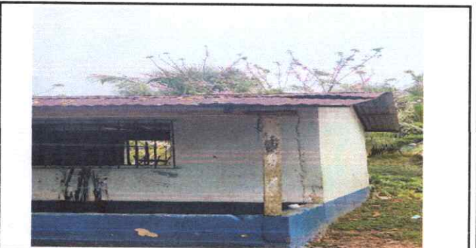
FOTO 6: Sustitución de parales de madera a metal
