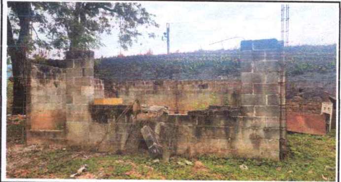
Foto 2: Reparación de Cocina
