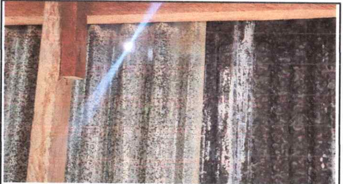
Foto 4: Cambio de techo de aula
