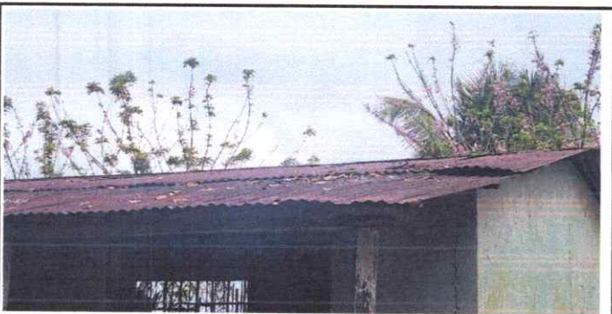
FOTO 5: Cambio de techo de escuela
