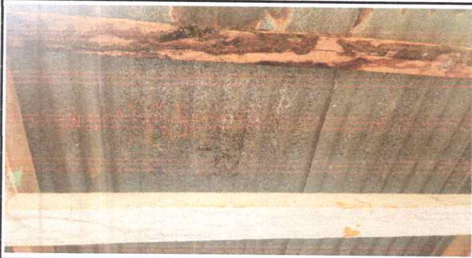
Foto 1: Cambio de Estructura de Madera por Metal y Cambio de Lámina
