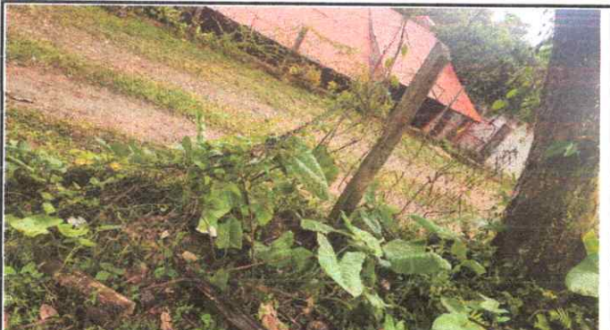
Foto 3: Reparación de Cernca perimetral de la escuela, cambio de postes de madera por tubos galvanizados y Malla.
