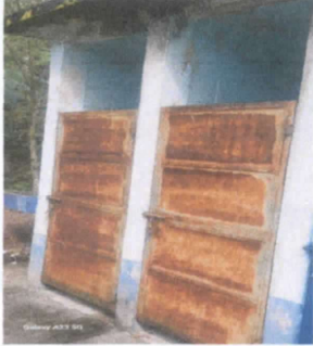
SUSTITUCIÓN EN PUERTAS DE METAL SERVICIOS SANITARIOS 3 MODULOS
