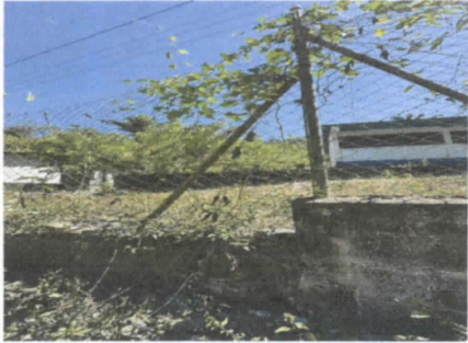
REPARACION DE MURO PERIMETRAL CON TUBO Y MALLA GALVANIZADA 42 METROS CUADRADOS
