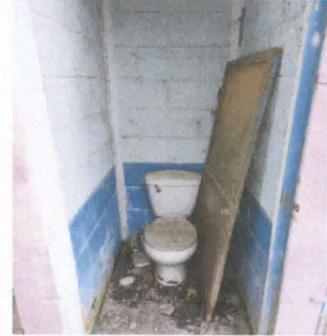
SUSTITUCION DE INODORO 3 MODULOS SANITARIOS
