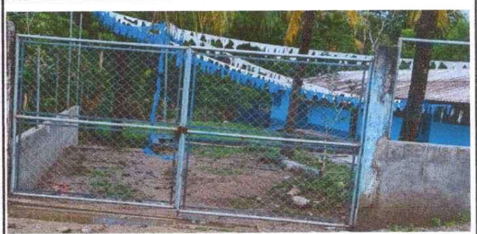
Foto 4: Sustitución de porton
