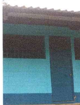
Foto 2: Sustitución de puertas de metal
