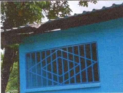
Foto 3: Sustitución balcon de ventanas
