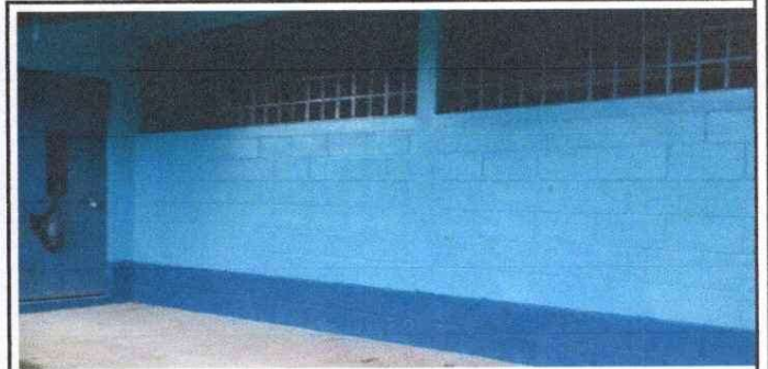
Foto 6: Pintura en muros interiores y exteriores
