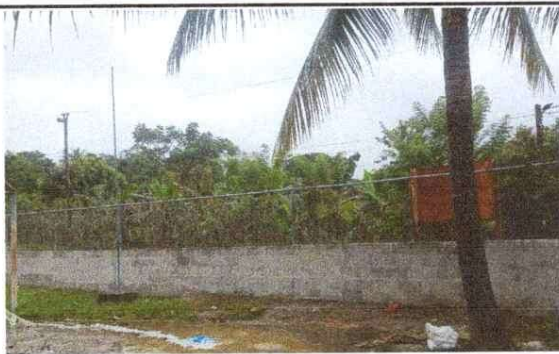
Foto 5: Reparación de muro perimetral de block y malla
