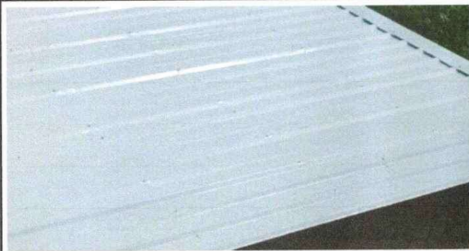
Foto 1: Sustitución de Lamina por lamina troquelada
