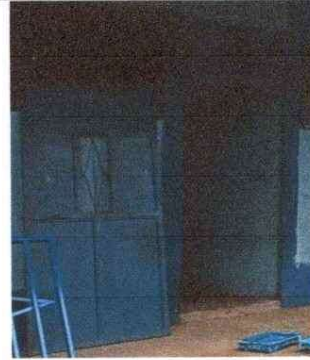
Foto 2: Sustitución de puertas de metal
