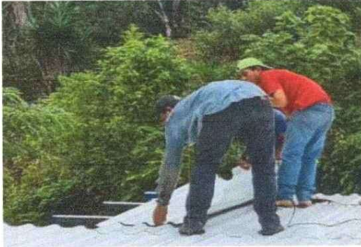
Foto1: Sustitución de Lamina por lamina troquelada
