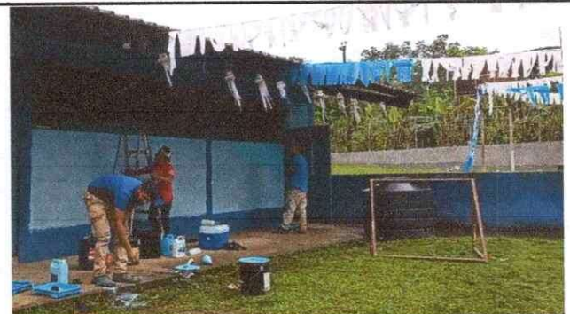
Foto 6: Pintura en muros interiores y exteriores
