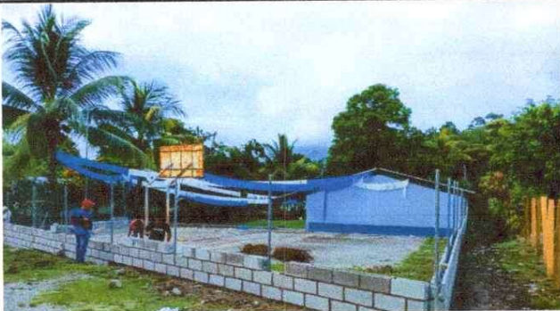
Foto 5: Reparación de muro perimetral de block y malla
