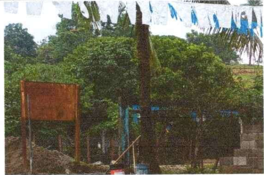
Foto 4: Sustitucion de porton
