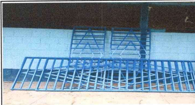
Foto 3: Sustitución balcon de ventanas
