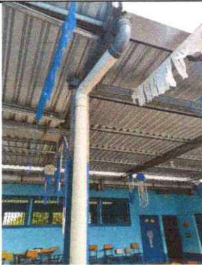
3.1 Sustitución de canal de metal
