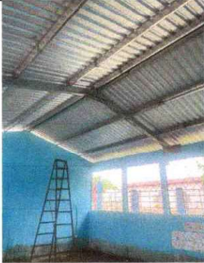
FOTO 1. sustitución de lámina de zinc por lámina troquelada aluzinc calibre 26
