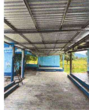
2.1 Sustitución de estructura de soporte de metal por metal
