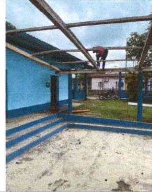
2.1 Sustitución de estructura de soporte de metal por metal
