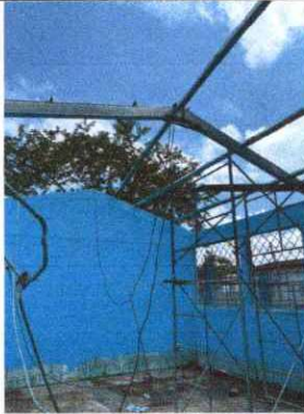
FOTO 1. sustitución de lámina de zinc por lámina troquelada aluzinc calibre 26
