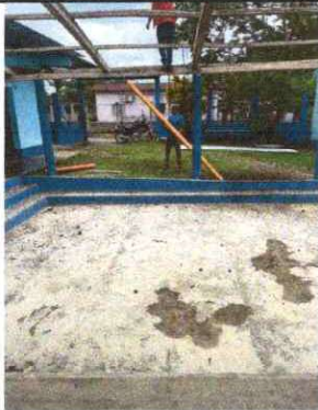
3.1 Sustitución de canal de metal
