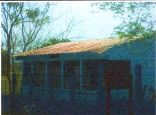
FOTO 1. sustitución de lámina de zinc por lámina troquelada aluzinc calibre 26
