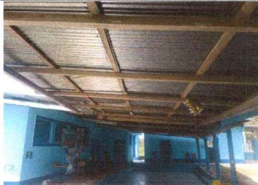
2.1 Sustitución de estructura de soporte de metal por metal
