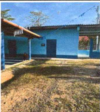
3.1 Sustitución de canal de metal
