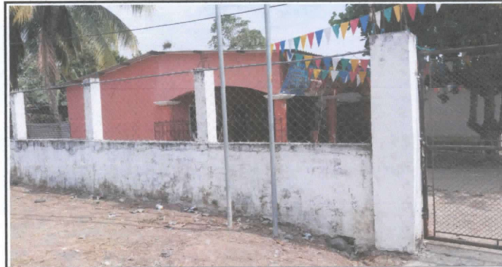
Situación de Muro Perimetral
