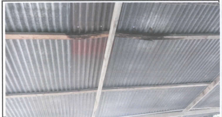
El soporte por ser de madera se pudrio y la lamina esta agujerada.
