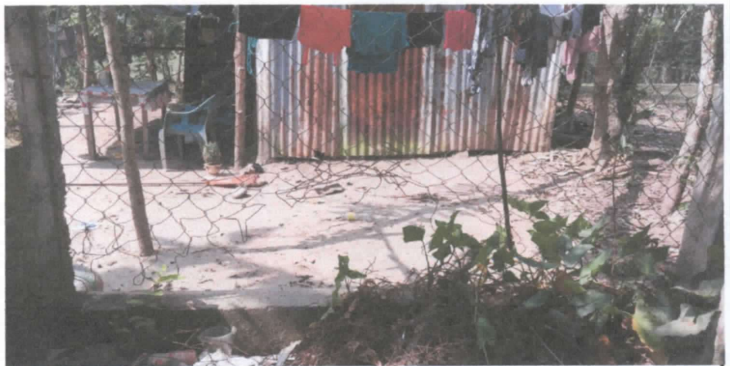
Partes de la malla se encuentra dañada.
