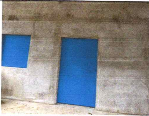
Foto 3: Reparación de repello y cernido de paredes
