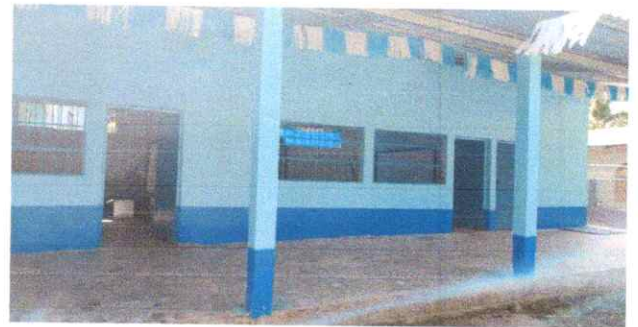
Sustitucion de balcon de ventana
