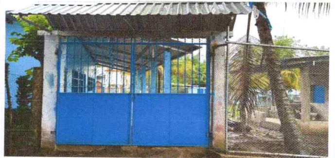
Sustitucion de porton de metal
