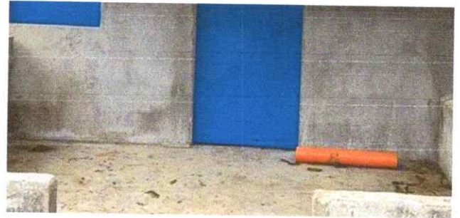
Foto 2: Sustitución de piso
