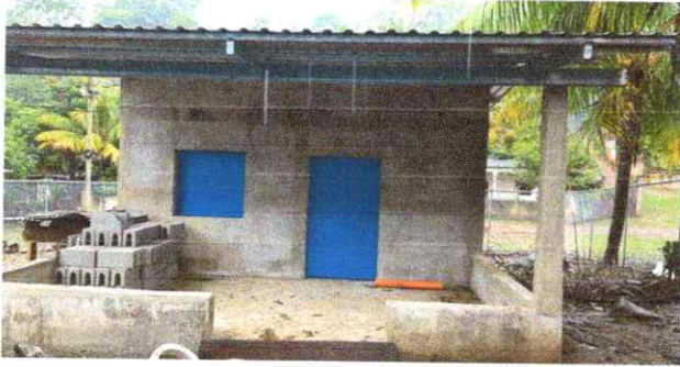
Sustitucion de lamina por lamina troquelada
