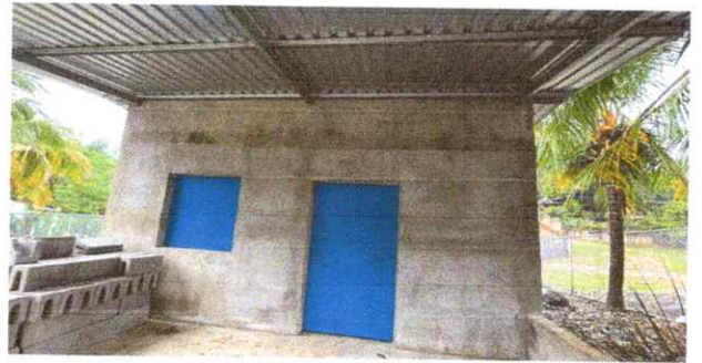
Sustitucion de estructura de soporte de madera por metal
