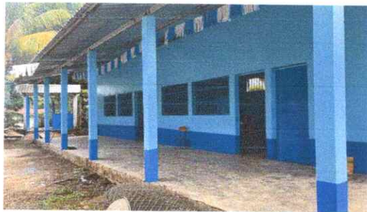
Pintura en muros exteriores e interiores
