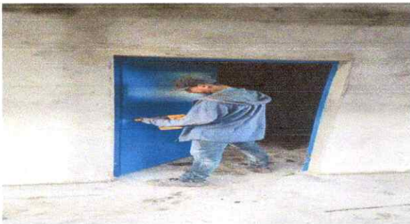
Sustitucion de puerta
