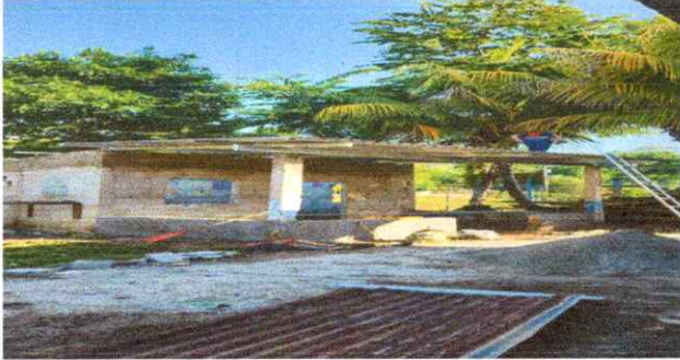
Sustitucion de lamina por lamina troquelada
