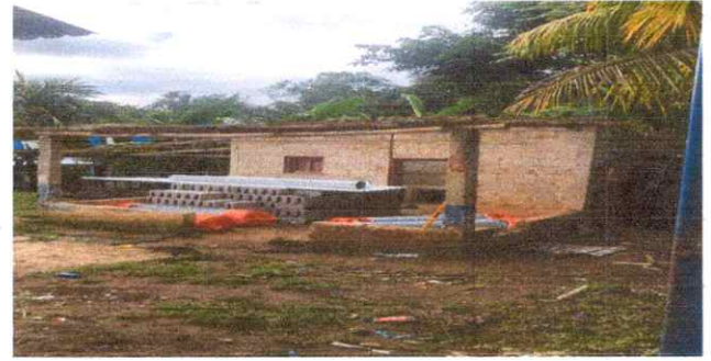
Sustitucion de estructura de soporte de madera por metal
