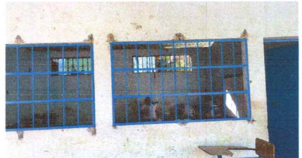
Sustitucion de balcon de ventana
