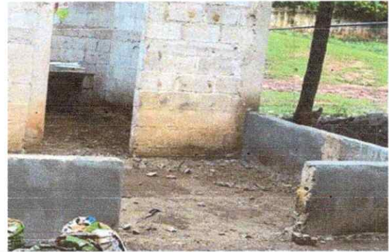
Foto 2: Sustitución de piso
