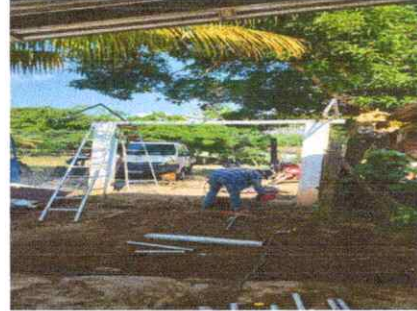
Sustitucion de porton de metal
