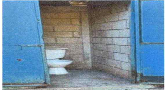
Foto 4: Accesorios en baños
