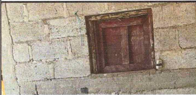
Foto 3: Reparación de repello y cernido de paredes
