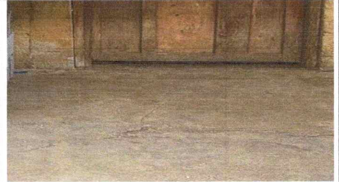
Foto 2: Sustitución de piso
