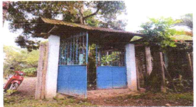
Sustitución de portón de metal
