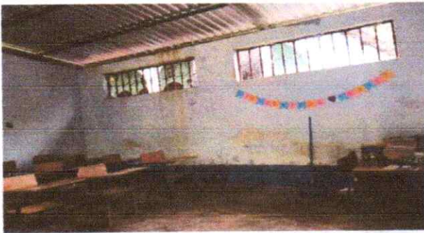
Pintura en muros exteriores e interiores
