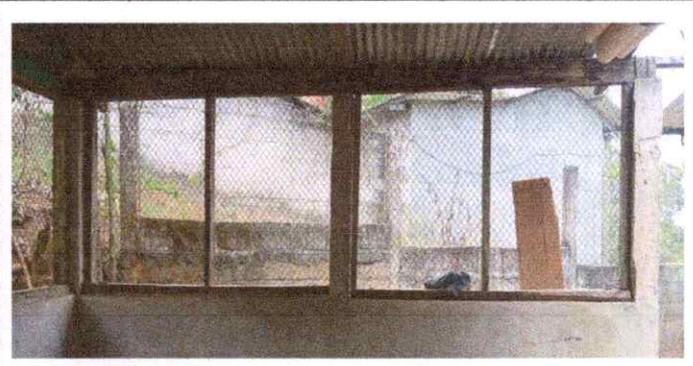
Sustitución de ventanas de madera por metal mas vidrio
