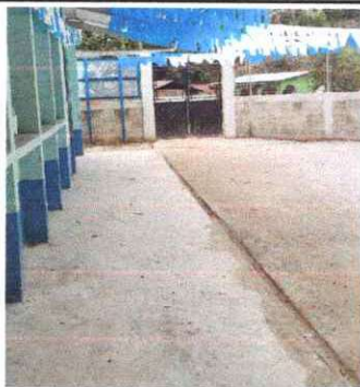
Foto 5: Sustitución de torta de cemento
