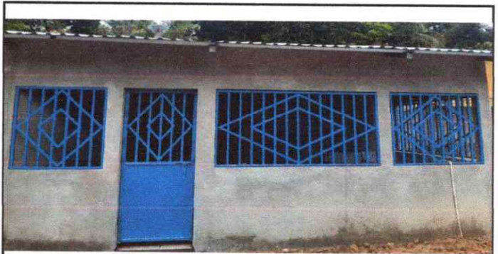
Foto 4: Fabricación e instalación de balcones metálicos (Cocina)
