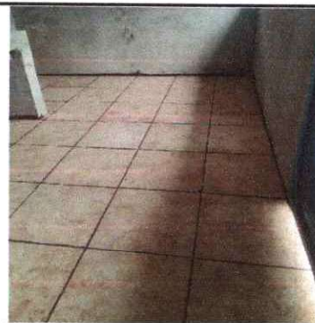
Foto 6: Instalación de piso de granito
