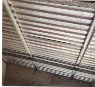
Foto 2: Sustitución de estructura de madera por metalica
