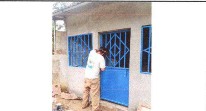
Foto 3: Instalación de puerta de metal (Cocina)
