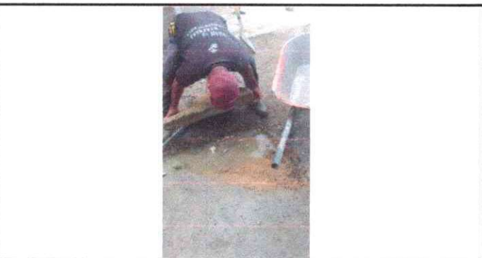
Foto 5: Sustitución de torta de cemento
