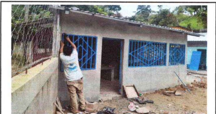
Foto 4: Fabricación e instalación de balcones metálicos (Cocina)
