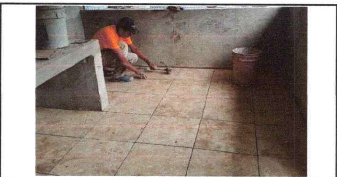
Foto 6: Instalación de piso de granito
