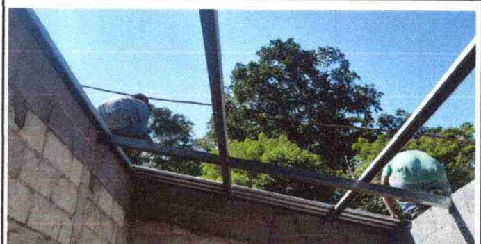
Foto 2: Sustitución de estructura de madera por metalica
