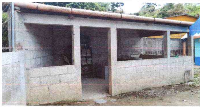
Foto 3: Instalación de puerta de metal (Cocina)
