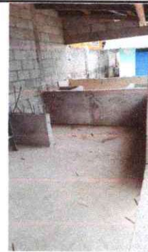
Foto 6: Instalación de piso de granito
