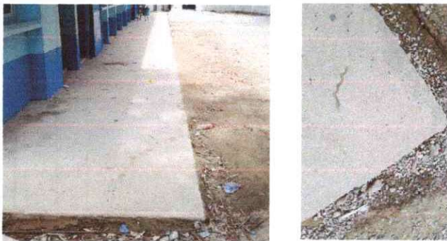
Foto 5: Sustitución de torta de cemento
