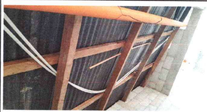
Foto 2: Sustitución de estructura de madera por metalica
