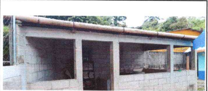
Foto 4: Fabricación e instalación de balcones metálicos (Cocina)
