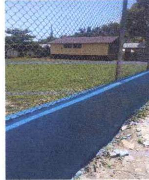
REPARACIÓN DE MURO PERIMETRAL DE BLOCK CON TUBO HG Y MALLA GALVANIZADA, SOLERAS INTERMEDIAS Y COLUMNAS.
