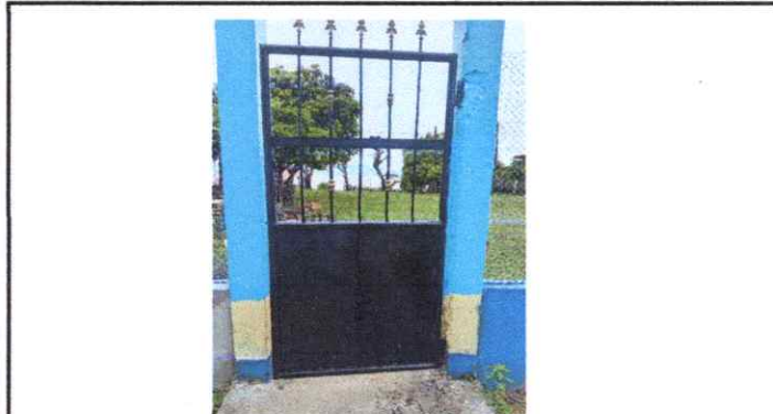
SUSTITUCIÓN DE PORTON DE METAL
