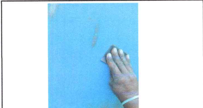
MANTENIMIENTO A ESTRUCTURA (LIJADO, CAMBIO DE TUBO, CEPILLADO, SUJECIONES, APLICACIÓN DE PINTURA) A PUERTAS SERVICIOS SANITARIOS
