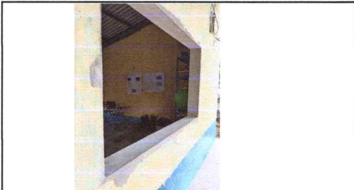
SUSTITUCIÓN DE VENTANA DE MADERA POR METAL MAS VIDRIO
