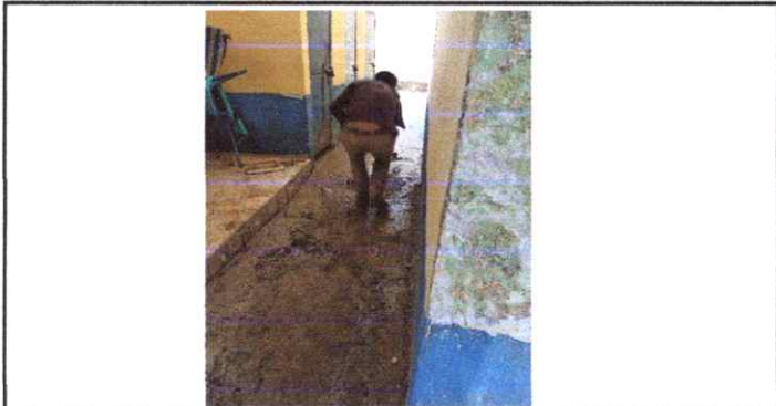
SUSTITUCIÓN DE PISO DE TORTA DE CONCRETO
