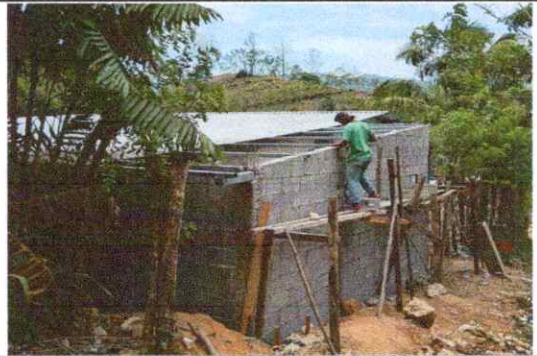
Cubierta de Lámina y Estructura de Techo
