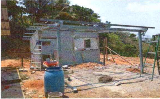
Cubierta de Lámina, Estructura de Techo y Reparación de Cocina
