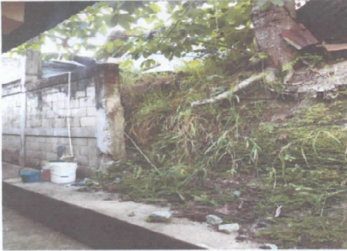
FOTO 1: SUSTITUCIÓN DE MURO DE CONTENCIÓN
