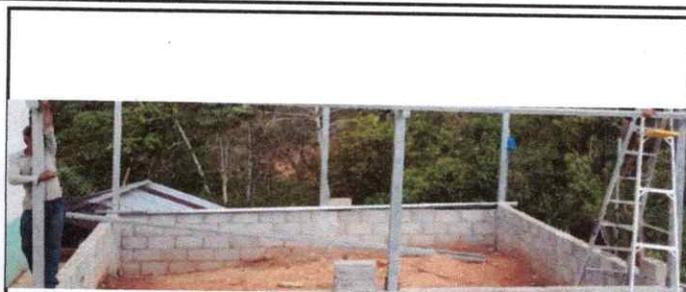
SUSTITUCIÓN DE ESTRUCTURA DE SOPORTE DE MADERA POR METAL
