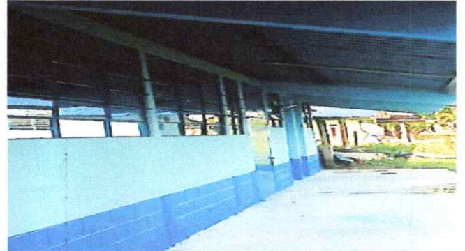
PINTURA DE MUROS INTERIORES Y EXTERIORES
