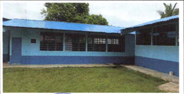
MANTENIMIENTO A LAMINA (LIJADO Y APLICACIÓN DE PINTURA.
