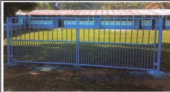
SUSTITUCION DE PORTONES DE INGRESO
