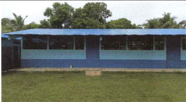
MANTENIMIENTO A LAMINA(LIJADO Y APLICACIÓN DE PINTURA)
