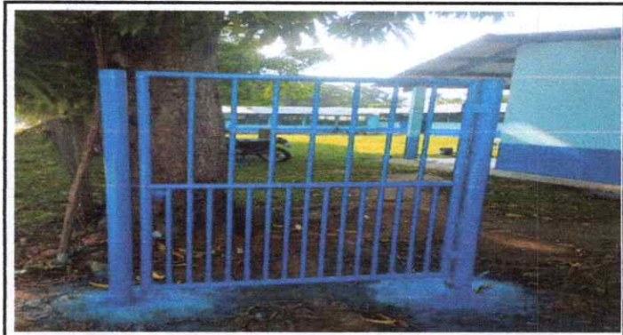
SUSTITUCION DE PORTONES DE INGRESO
