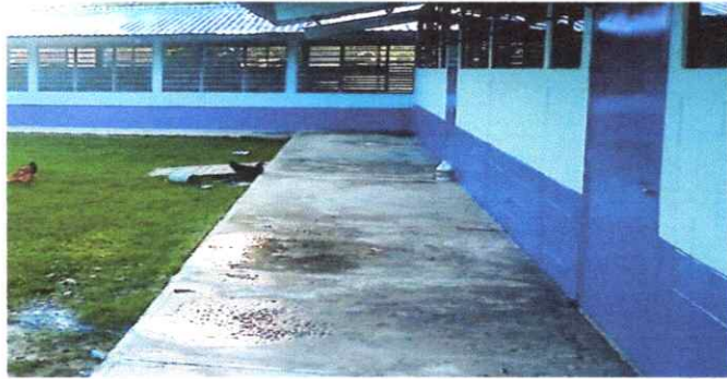
PINTURA DE MUROS INTERIORES Y EXTERIORES
