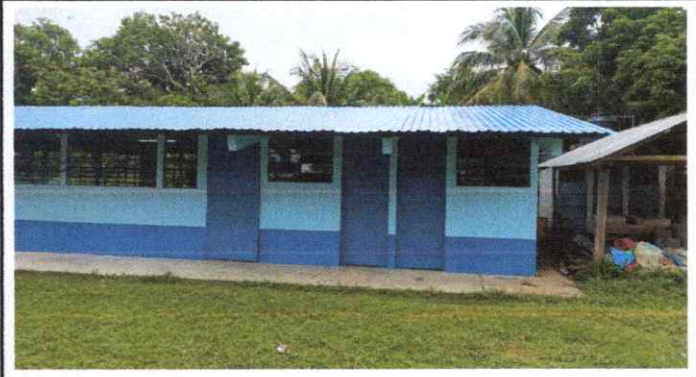
MANTENIRNTO A LAMINA (LIJADO Y APLICACIÓN DE PINTURA)
