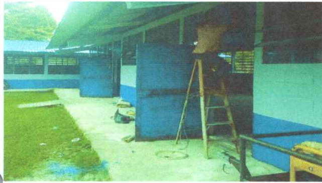
PINTURA DE MUROS INTERIORES Y EXTERIORES
