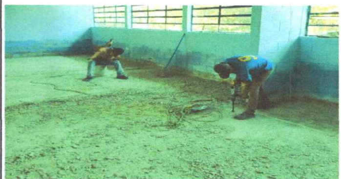
SUSTIRUCION DE PISO DE TORTA DE CONCRETO A PISO CERAMICO
