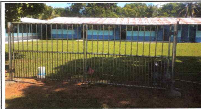
SUSTITUCION DE PORTONES DE INGRESO
