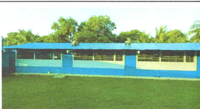
MANTENIMIENTO A LAMINA(LIJADO Y APLICACIÓN DE PINTURA)
