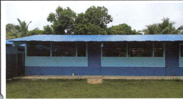
MANTENIMIENTO A LAMINA (LIJADO Y APLICACIÓN DE PINTURA)
