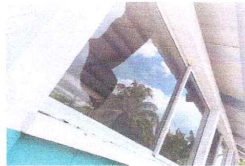
Ventanas: sustitucion de vidrios
