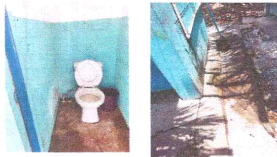
Sustitucion de inodoros
