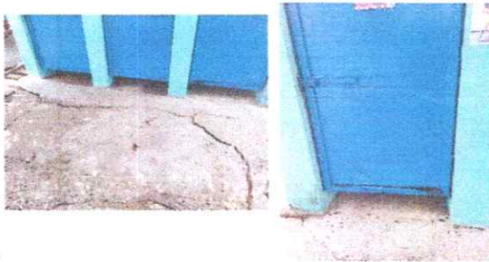
Puertas de metal: sustitucion de puertas
