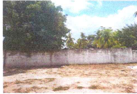
Pintura de muro interiores y exteriores
