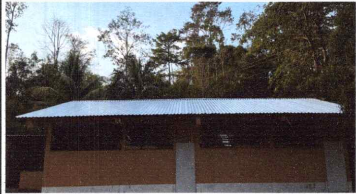
Sustitución de Lámina
