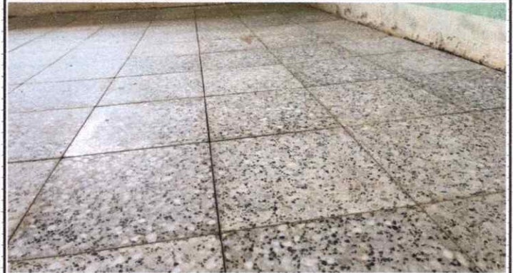
Sustitución de Piso de Granito
