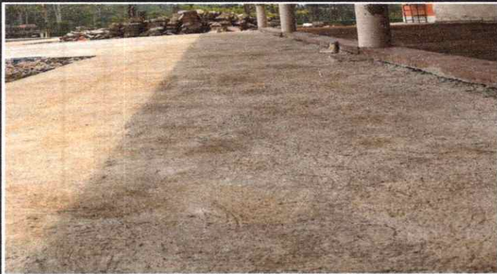
Reparación de Banqueta de Concreto
