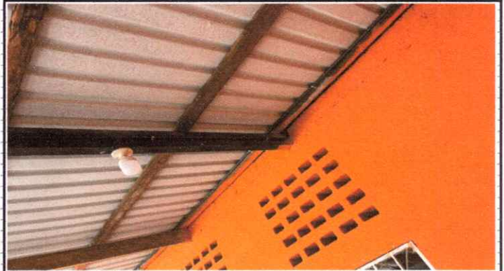
Reparación Sistema Eléctrico
