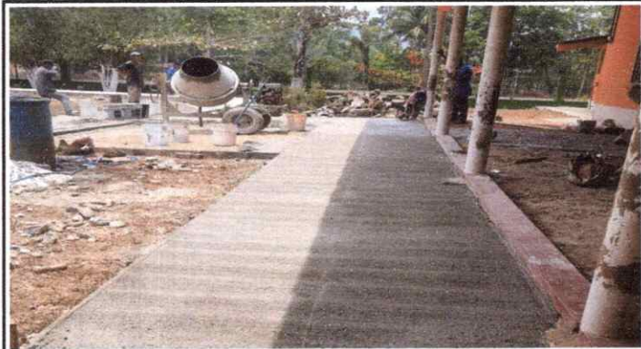
Reparación de Banqueta de Concreto
