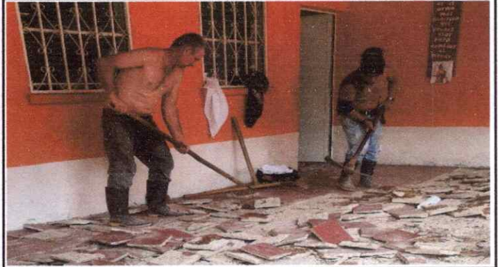
Sustitución de Piso de Granito
