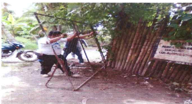
FOTO 3. REPARACIÓN TOTAL DEL PORTÓN PRINCIPAL DEL ESTABLECIMIENTO QUE BRINDARÁ SEGURIDAD A LA COMUNIDAD EDUCATIVA.
