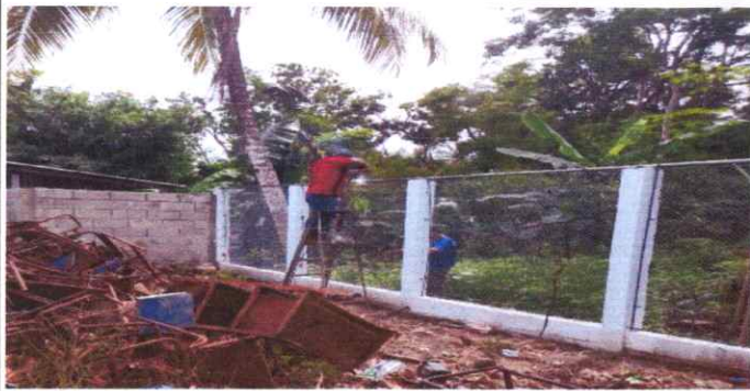
FOTO 1. REPARACIÓN TOTAL DE MALLA QUE CIRCULA EL PREDIO ESCOLAR.
