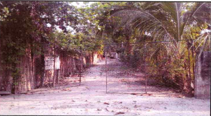
FOTO 3 MANTENIMIENTO A PORTONES DE METAL
