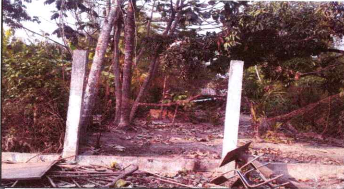
FOTO 1 REPARACION DE TUBO GH Y MALLA GALVANIZADA
