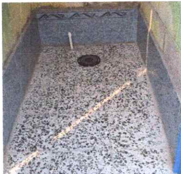
Sustitución de cerámico
