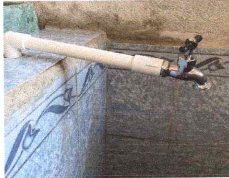
Sustitución de llaver de chorro
