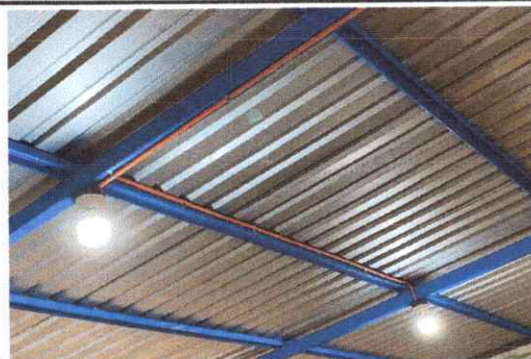
Reparación de cableado eléctrico
