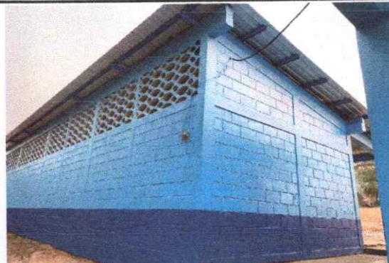
Pintura de muros exteriores e interiores
