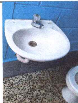
Sustitución de lavamanos
