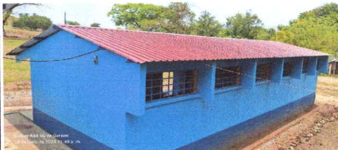
Pintura de techo de dos aulas. Según acta No. 10-2024
