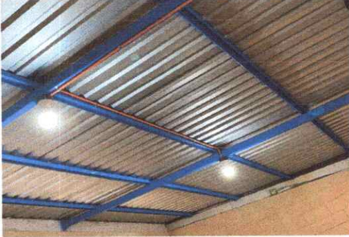
Sustitución de ducto eléctrico + accesorios
