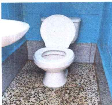
Sustitución de baño
