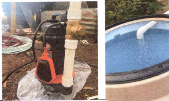
Sustitución de bomba de agua
