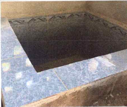
Reparación de cisterna de concreto
