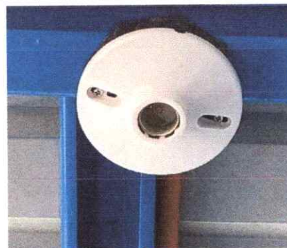
Sustitución de plafoneras
