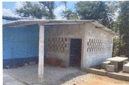
Repello en muro
