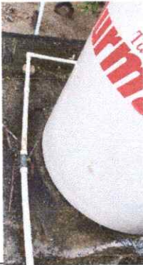
Sustitución de tubería principal
