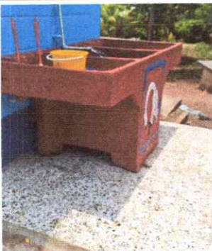
Sustitución de pila de cemento de dos lavadores
