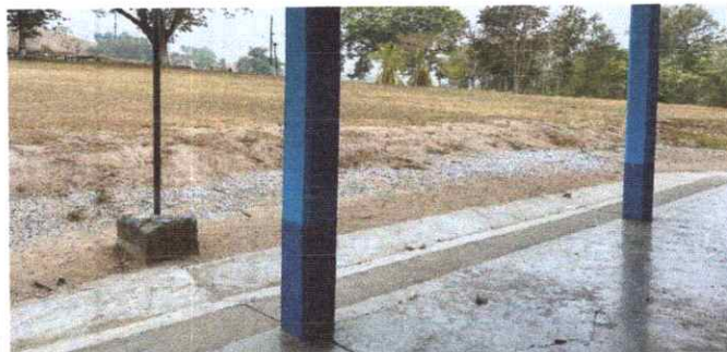
Reparación de cuneta de concreto
