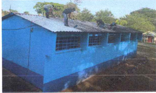
Sustitución de canales. Se sustituye por pintura de dos aulas según acta No. 10-2024
