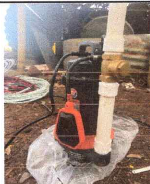
Sustitución de bomba de agua
