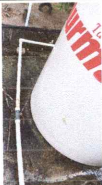
Sustitución de tubería principal
