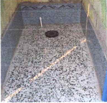
Sustitución de cerámico
