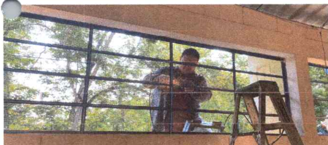
Mantenimiento a estructura de metal de ventana
