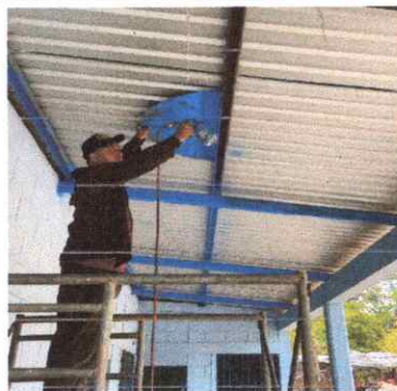
Mantenimiento a estructura de soporte de metal
