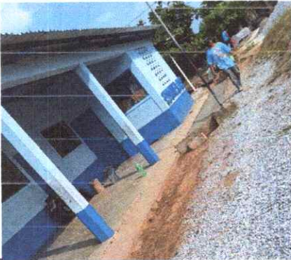
Reparación de cuneta de concreto
