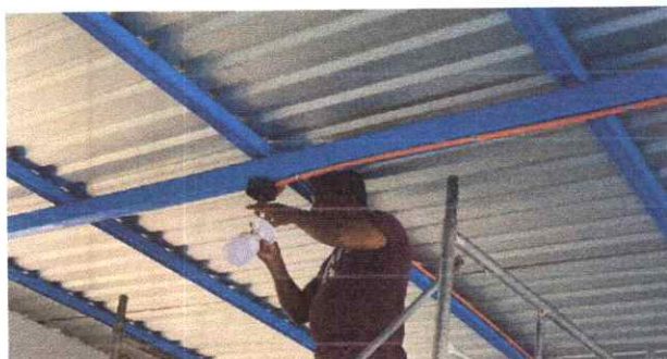
Sustitución de focos ahorradores
