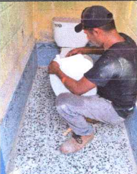
Sustitución de baño
