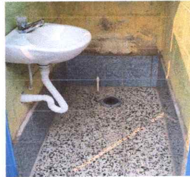
Sustitución de lavamanos
