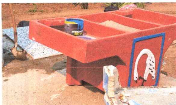
Sustitución de pila de cemento de dos lavadores
