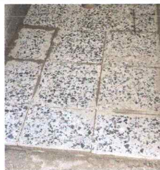
Reparación de piso cerámico
