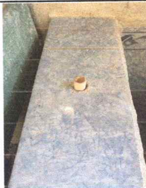
Sustitución de llaver de chorro
