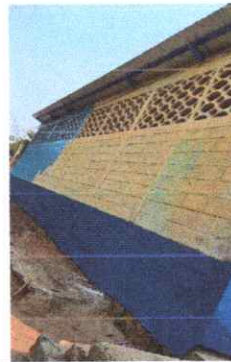
Pintura de muros exteriores e interiores
