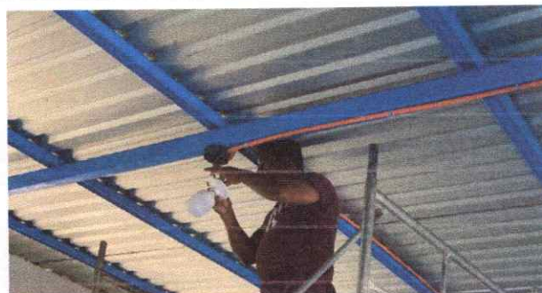
Sustitución de plafoneras
