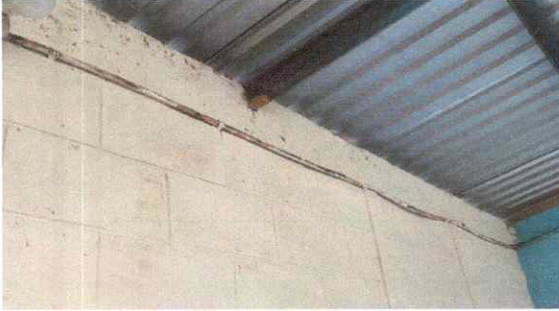
Sustitución de ducto eléctrico + accesorios
