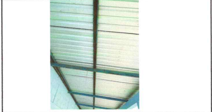
Mantenimiento a estructura de soporte de metal
