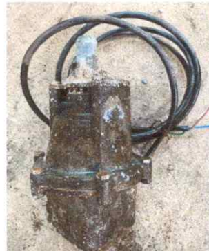
Sustitución de bomba de agua
