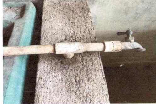
Sustitución de llaver de chorro
