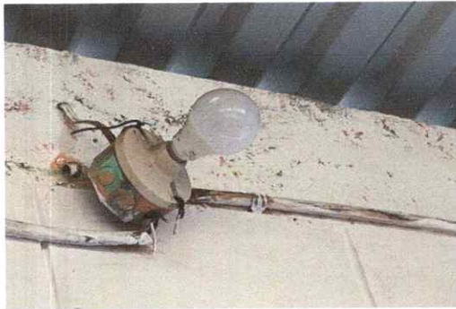
Sustitución de focos ahorradores
