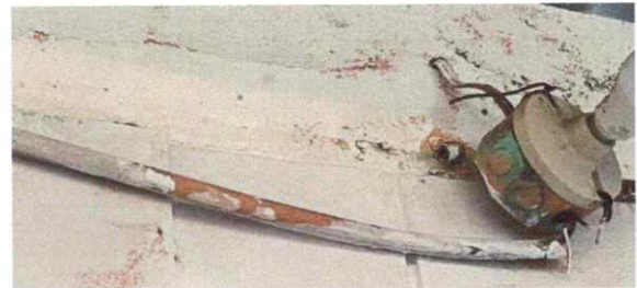
Reparación de cableado eléctrico
