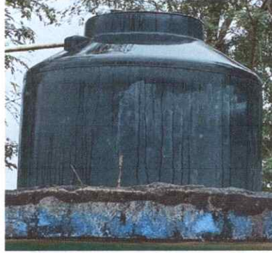
Sustitución de depósito de agua 1100 lt
