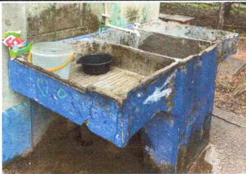
Sustitución de pila de cemento de dos lavadores
