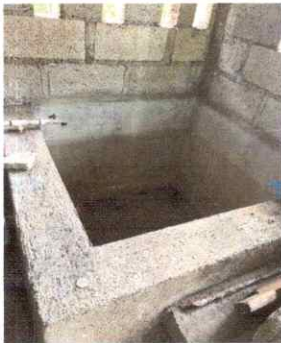
Reparación de cisterna de concreto
