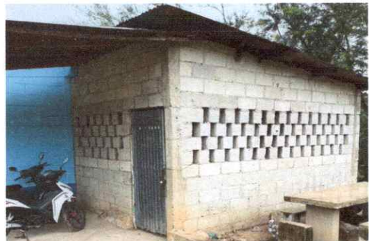
Repello en muro
