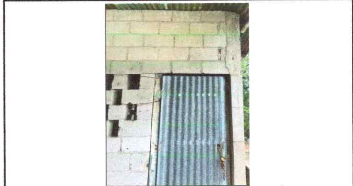
Sustitución de puerta
