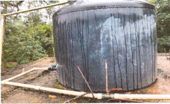
Sustitución de tubería principal
