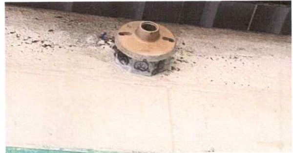
Sustitución de plafoneras
