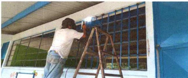
Foto 5: SUSTITUCION DE ESTRUCTURA DE METAL DE VENTANA
