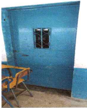
Foto 3: MANTENIMIENTO A ESTRUCTURA DE PUERTAS DE METAL Y SUSTITUCIÓN DE CHAPA
