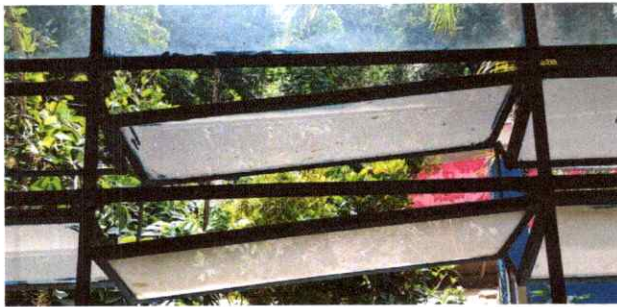
Foto 5: SUSTITUCION DE ESTRUCTURA DE METAL DE VENTANA
