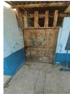
Foto 4 : SUSTITUCIÓN DE PUERTA
