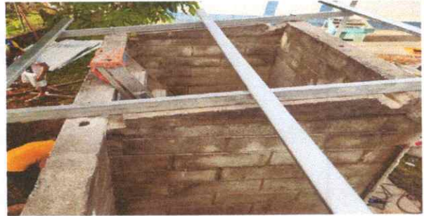
Foto 2: Sustitución de estructura de soporte de madera, por metal
