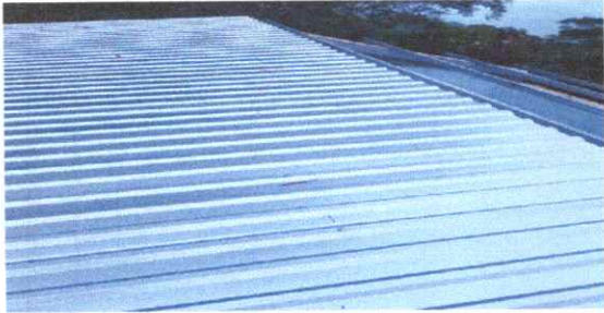
Foto1: Sustitución de lámina, por lámina aluzinc
