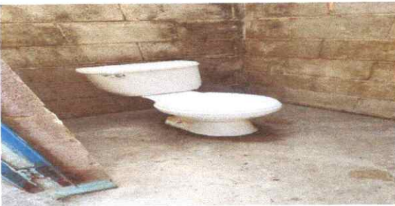
Foto 5: Sustitución de inodoros
