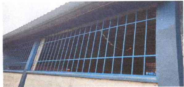
Foto 4: Sustitución de estructura de metal de ventana
