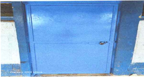
Foto 3: Mantenimiento de estructura
