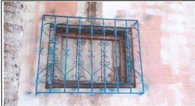
Mantenimiento a balcones de metal
