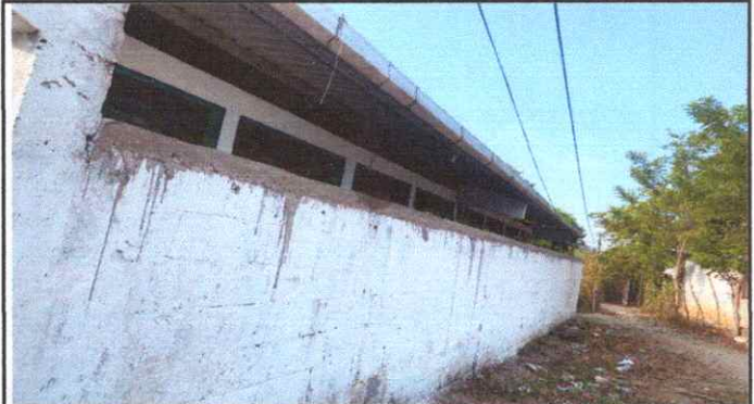
Reparación de muro perimetral de block
