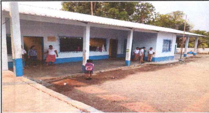
Sustitución de lamina por lamina troquelada
