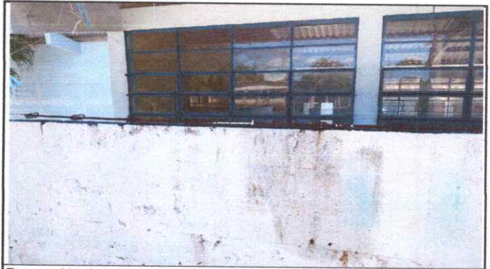
Reparación de muro perimetral de block
