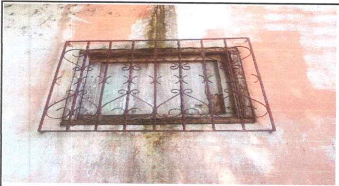
Mantenimiento a balcones de metal
