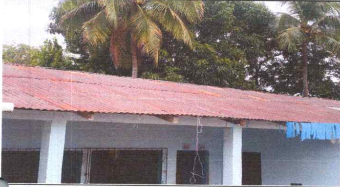
Sustitución de lamina por lamina troquelada
