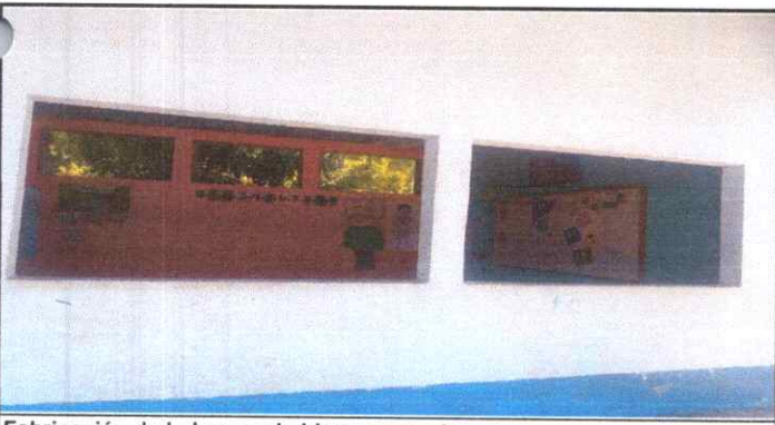
Fabricación de balcones de hierro en ventanas
