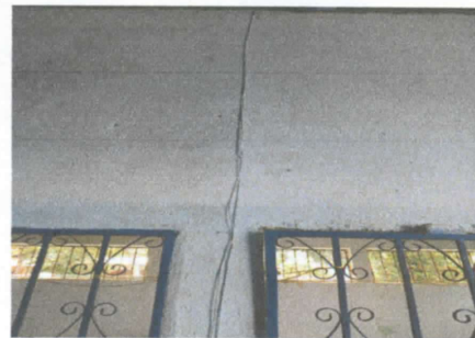
Foto 12. Sustrucion de cableado electrico
