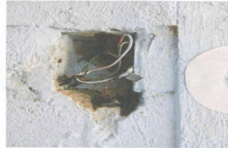
Foto 10. Sustrucion de flipones
