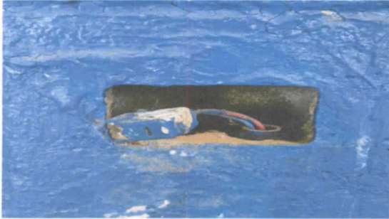
Foto 9. sustitucion de tomacorriente doble
