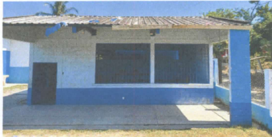
Foto 1. Sustitucion de lamina por lamina troquelada
