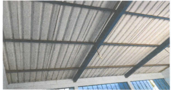
Foto 2. Sustitucion de estructura de soporte de matal por metal
