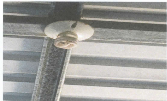
Foto 6. Sustitucion de lamparas
