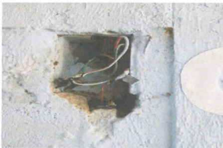
Foto 11. Sustrucion de tablero
