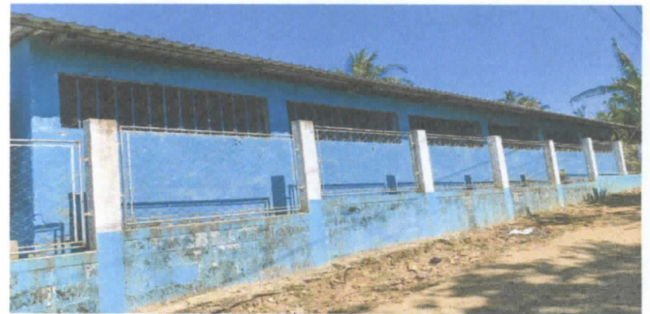
Foto 4. Pintura en muros exteriores e interiores
