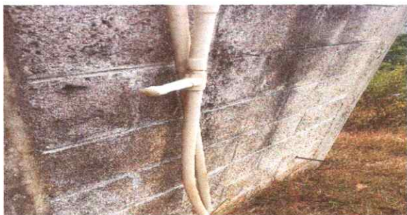
Foto 3: Cambio total de Tubería.
