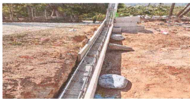
Foto 2: Inicio de los trabajos de lo que será el nuevo muro perimetral el cual brindará seguridad a las instalaciones del establecimiento educativo.
