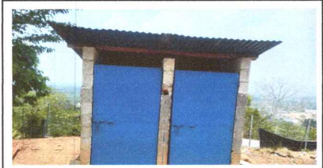
Foto 1: Colocación y reparación de las instalaciones sanitarias de la escuela.
