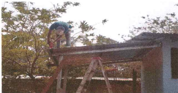
Foto 1: Trabajando en la reparación y colocación del nuevo techo.
