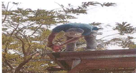
Foto 5: Trabajos de cambio y renovación de láminas de techo.
