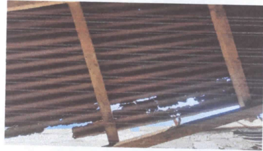
Sustitución Lámina troquelada de zinc
