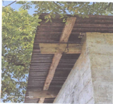
Sustitución de estructura de soporte de madera por metal
